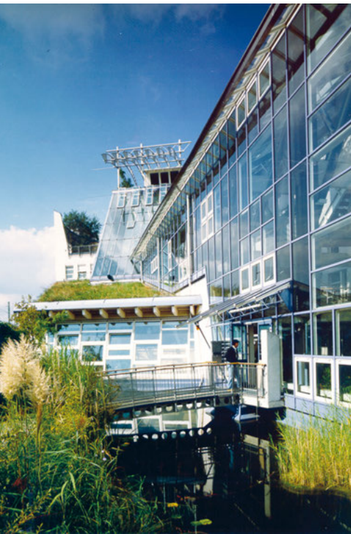
Das Ökohaus in Frankfurt am Main
