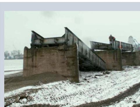
Abb. 2 Abriss der Eisenbahnbrücke in der Ostra-Flutrinne zur Verbesserung des Hochwasserabflusses der Elbe
